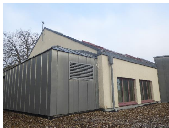
Abbildung 5: Blick auf das Dach des Gebäudes der Musikakademie.
