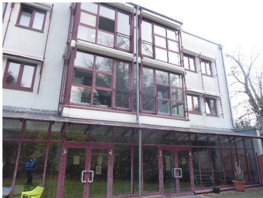
Abbildung 3: Gebäude der Musikakademie im B-Plangebiet.
