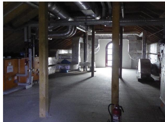
Abbildung 4: Blick auf den Dachboden.
