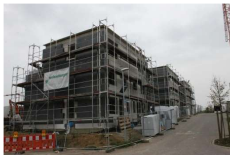
Wohnpark am Bahnhof in Flehingen
