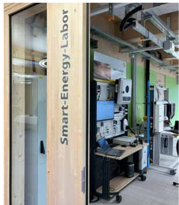
Einweihung des neuen Schulpavillons mit Smart-Energy-Labor und Unterrichtsräumen der Karl-Berberich-Schule
