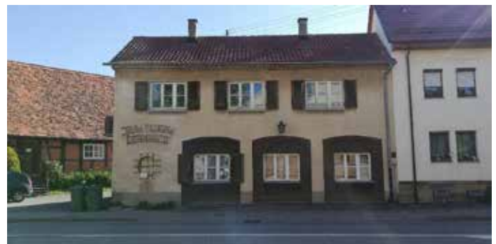
Sternenfelser Straße vor den Abrissarbeiten
