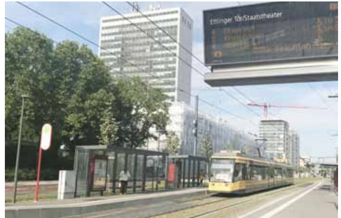
Derzeit laufen die Rückbauarbeiten am früheren Langbau.
